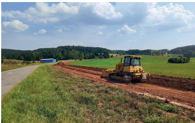
Budování cyklostezky na Písečnou
