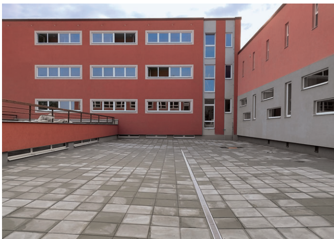
Opravená terasa na základní škole
