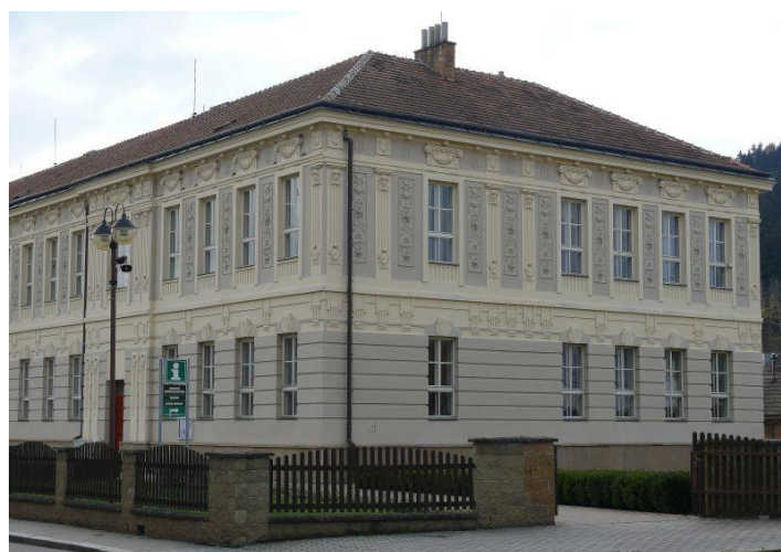
Budova Tyršova 2, Letovice
